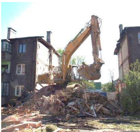
Rys. 7. Widok na wyburzany segment ciągu a
