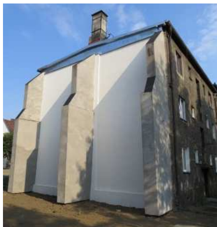
Rys. 8. Widok wykonanych przypór w ciągu c
